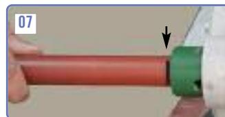
El tubo debe introducirse, sin sobrepasar la marca de profundidad de penetración.
