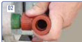
Introduzca la conexión en la boquilla hasta hacer tope. Cuando se haya cumplido el tiempo de calentamiento, retire la conexión de la boquilla y apóyela, sobre una superficie limpia, seca y a resguardo de corrientes de aire.
